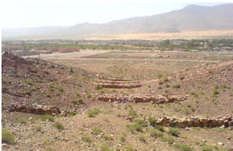
**Figure 20 : Les seuils en pierres sèches (Melalih, 2012).**
