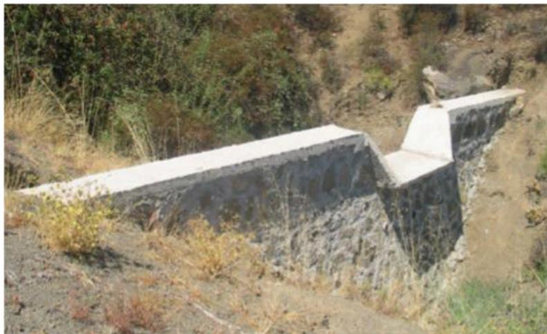
Figure 21 : Seuils en pierres cimentées (HCEFLD, 2014).
