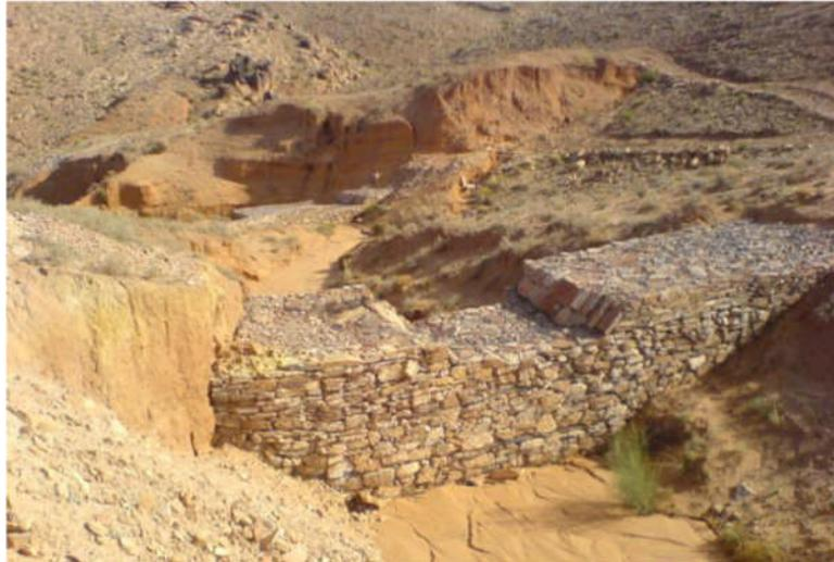
**Figure 19 : Les seuils en gabion utilisées dans la fixation des ravines (Melalih, 2012).**
