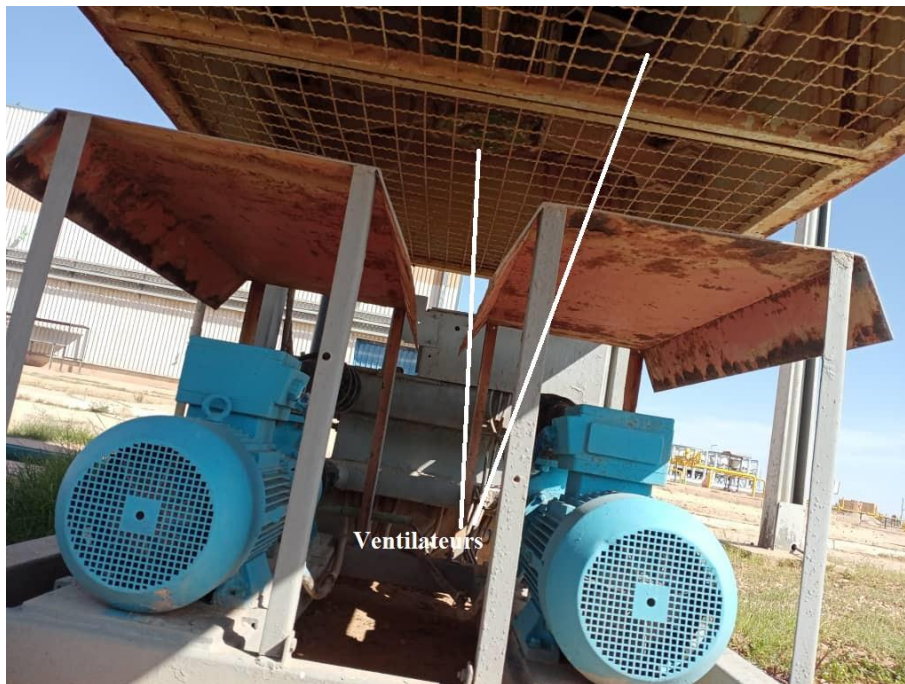
Figure II.5 : Position des ventilateurs du système Aero réfrigérant
