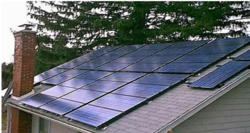
Figure II.13 : Défaut d'ombrage
