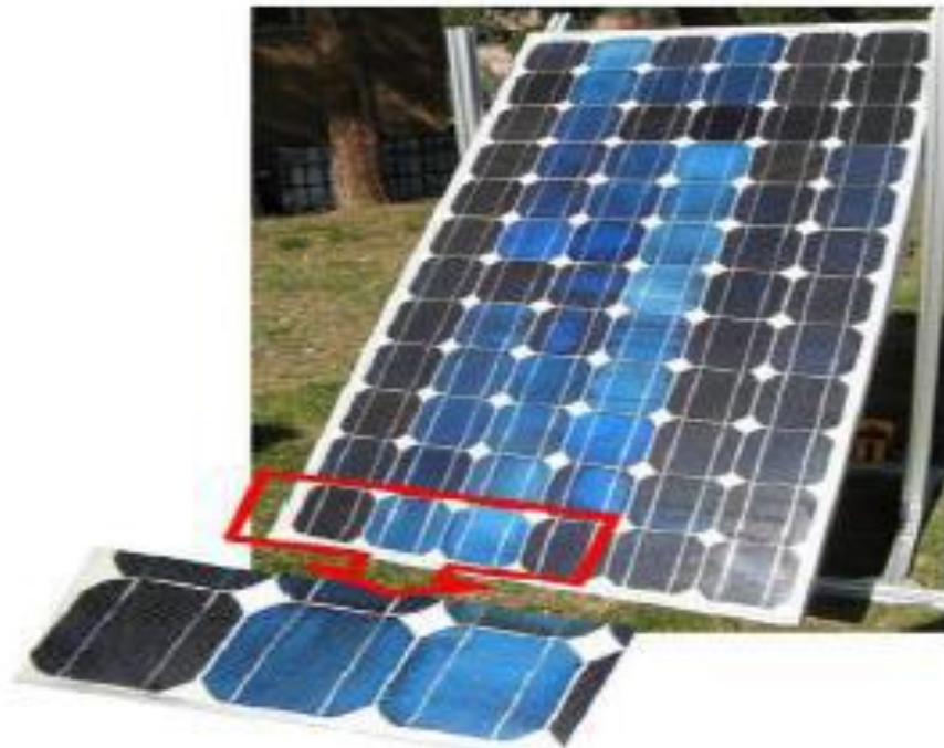
Figure II.7 : défaut de revêtement anti –reflet.
