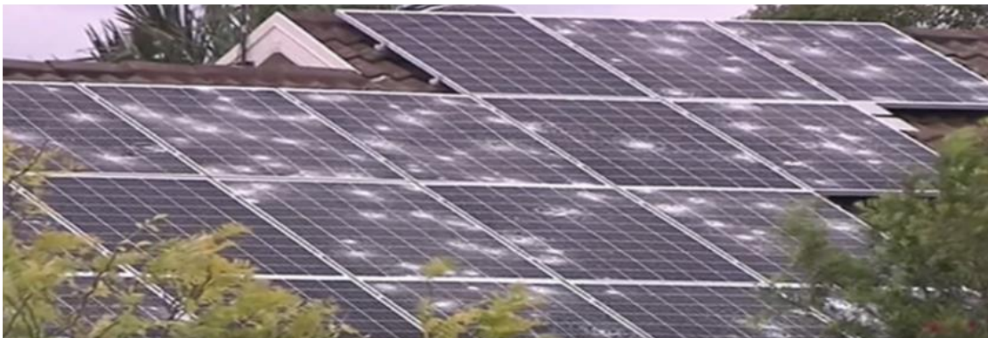
Figure II.10 : Défaut de bulles d’air
