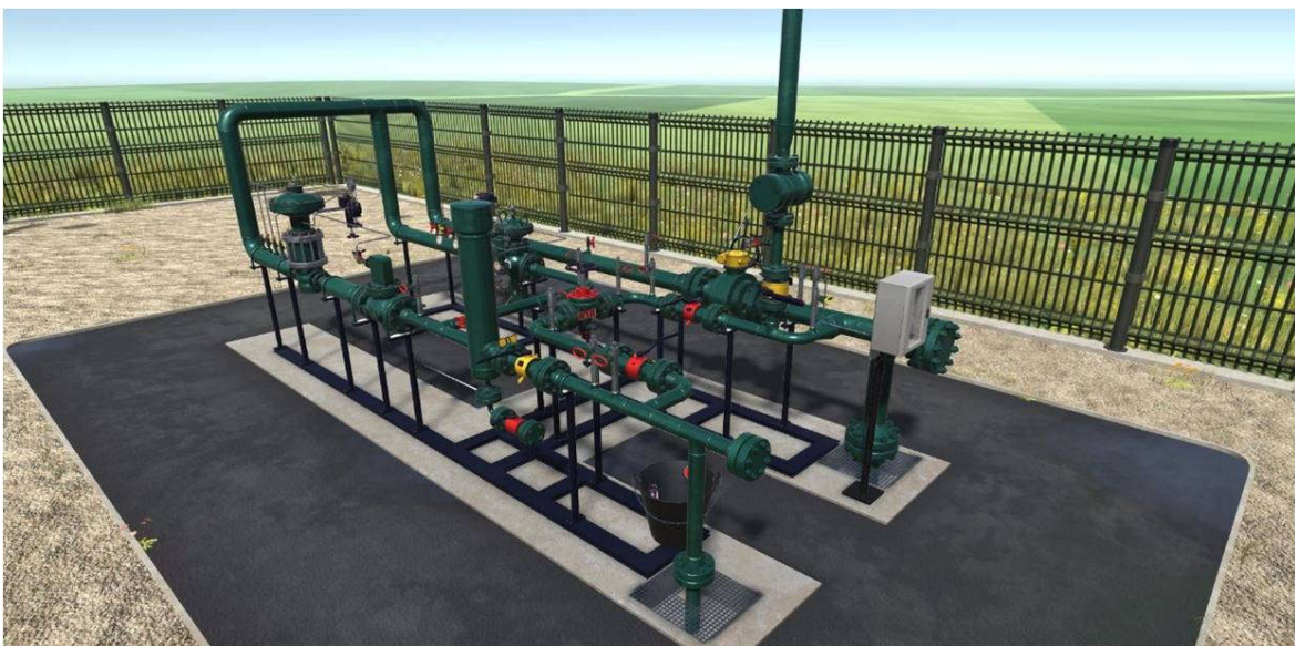
Figure 1.4 : Schéma poste de détente gaz [15].
