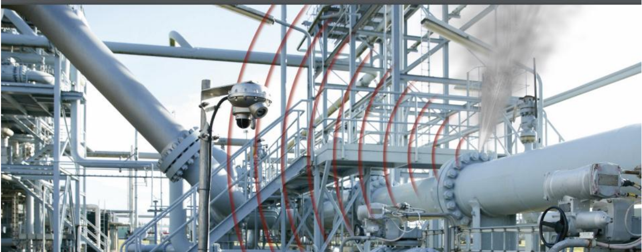
La figure 2.7: Détecteur de fuites de gaz à ultrasons OBSERVER-I [21]
