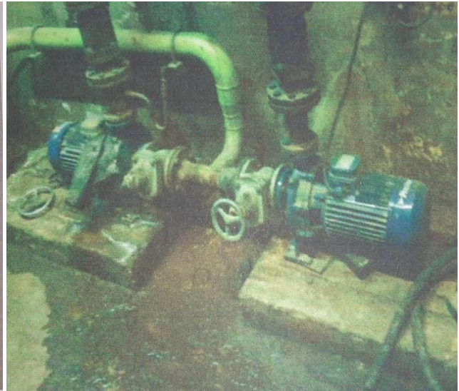
Figure 3.10 : vue des deux pompes du de système système de refroidissement du four[32]
