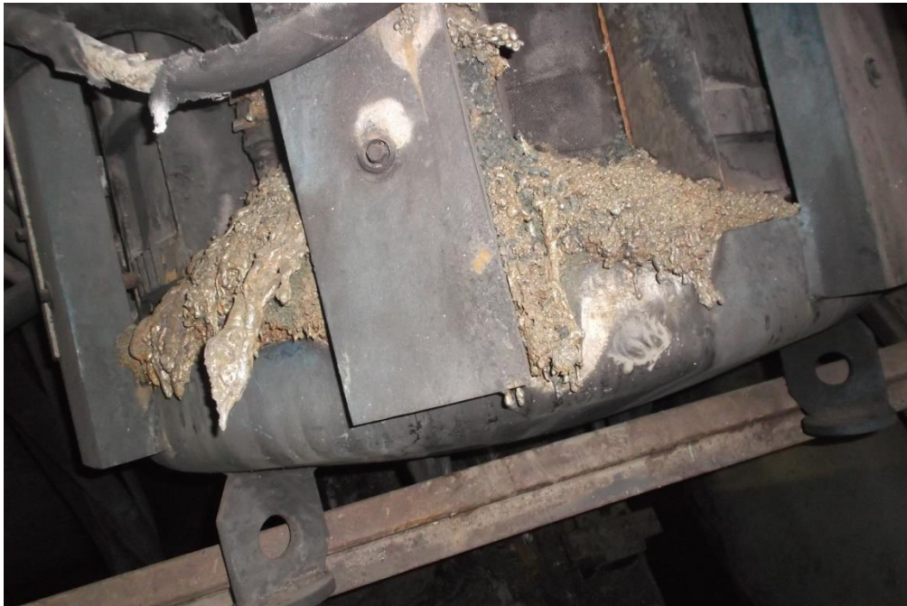
Figure 3.14 : fuite de matériau fondu.[prenezde ALFET]
