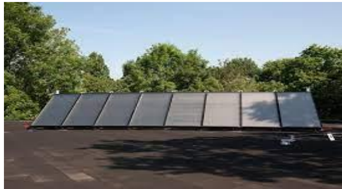
Figure I. 14 : L'ombrage partiel sur les panneaux photovoltaïques
