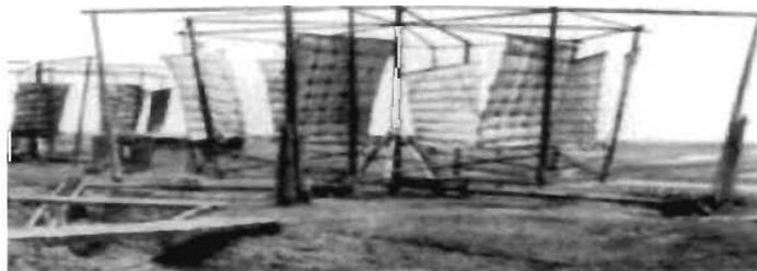
**Figure I.2 :** Moulin à vent destinée au pompage d'eau, Chine [1]
