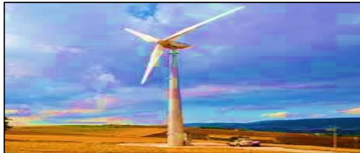
Figure I.8 :Les éoliennes à axe horizontal
