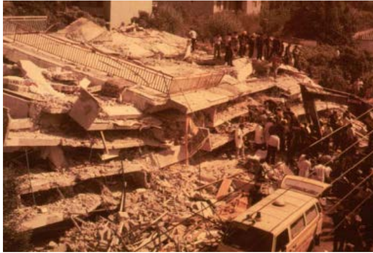
Figure II.19 : Séisme de Kalamata – Document x - Ce type de ruine par empilement des dalles est typique d'une absence de contreventement vertical
