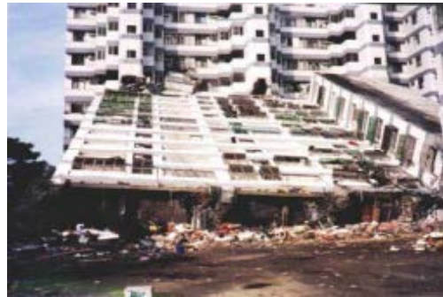
Figure II.5 : Renversement de l'immeuble
