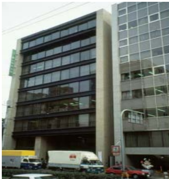
Figure II.15 : (Japon, Document X) - Joint parasismique vertical large entre deux constructions susceptibles de présenter des déformations importantes en partie supérieure
