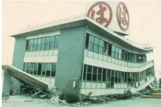
Figure II.12 : flexibilité du bas de la construction
