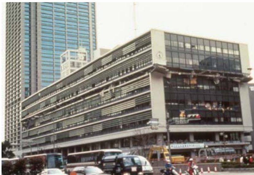
Figure II.18 : Variation de raideur entre les étages du bas et du haut
