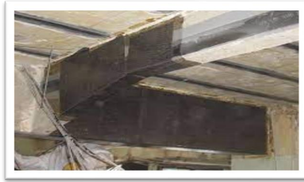
Figure 6: renforcement de béton en matériau composite
