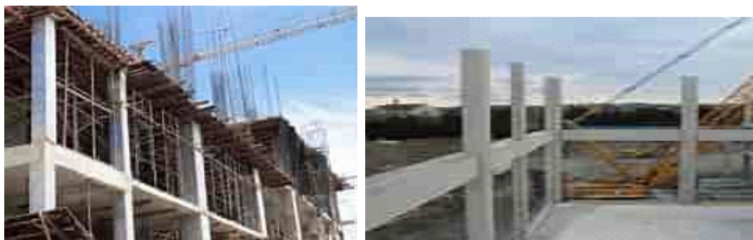
Figure II.4: poutres en béton [6]
