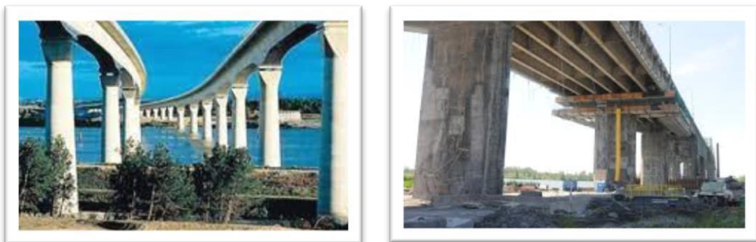
Figure (2.1) : Ponts en bétons à hautes performances (BHP)
