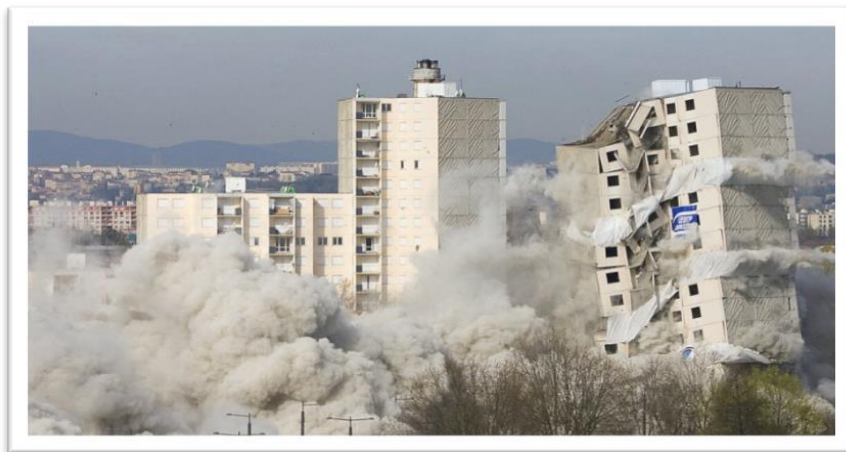
Figure (1.7) : Démolition à l'aide d'une tenaille [19]
