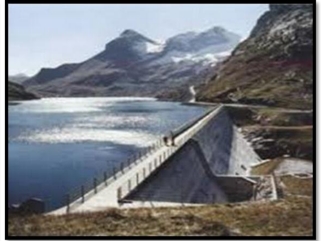
Figure II.6 : Image d'un barrage Poids
