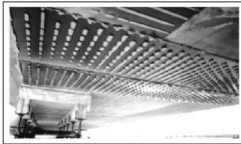
Figure II.6: Renforcement d'un viaduc par tôles collées. [(Boulaziz, A).2014],
