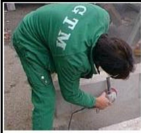
Ponçage de la surface
