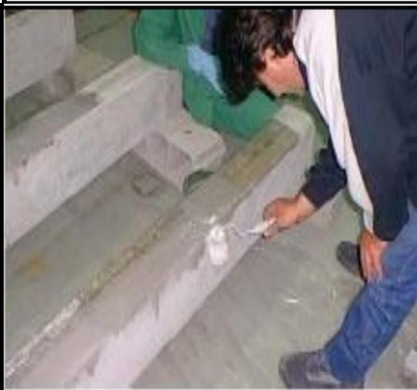
Mise en place de la résine
