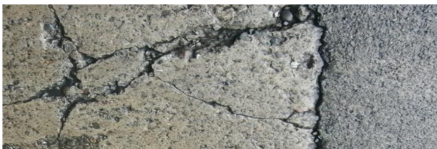
Figure I.5 : Retrait du béton [(Deghmane Y, Riou O).2018].
