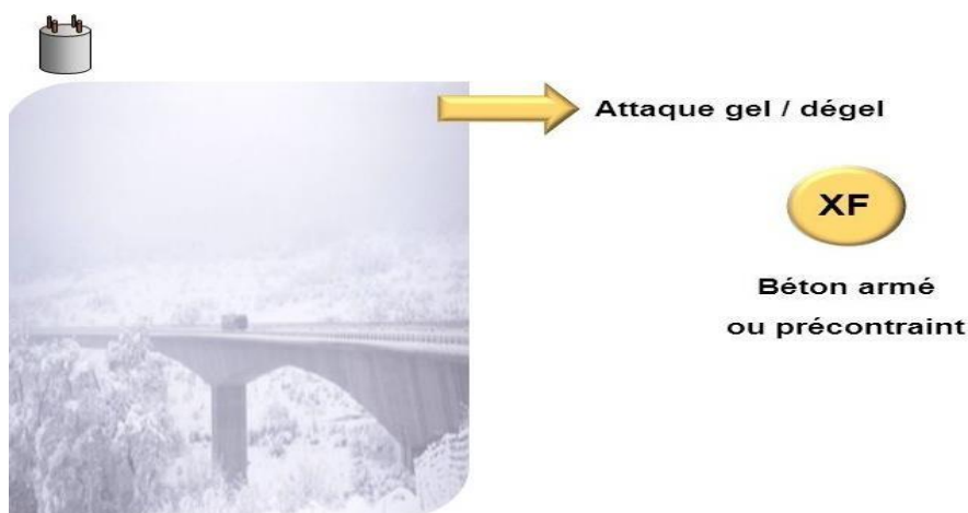
Figure I.2 : gel-dégel du béton [(Deghmane Y, Riou O).2018]
