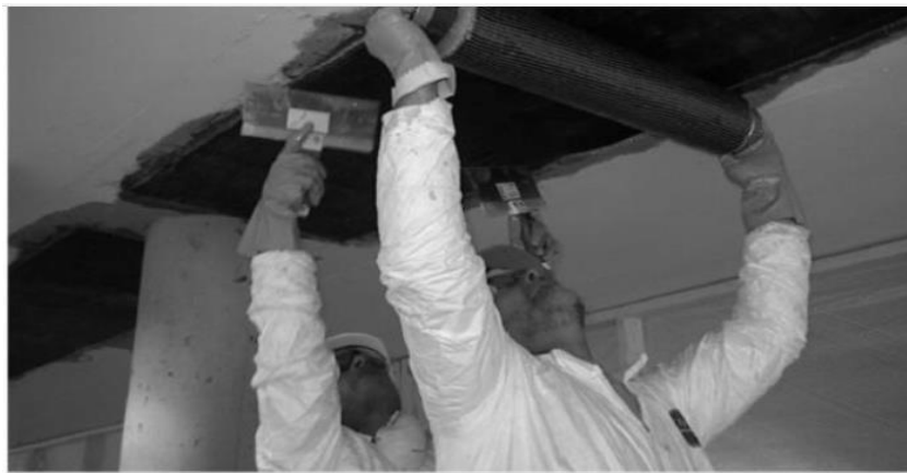
Figure II.9: Mise en œuvre d'une réparation par matériaux composites. [(Amjad kreit).2012]
