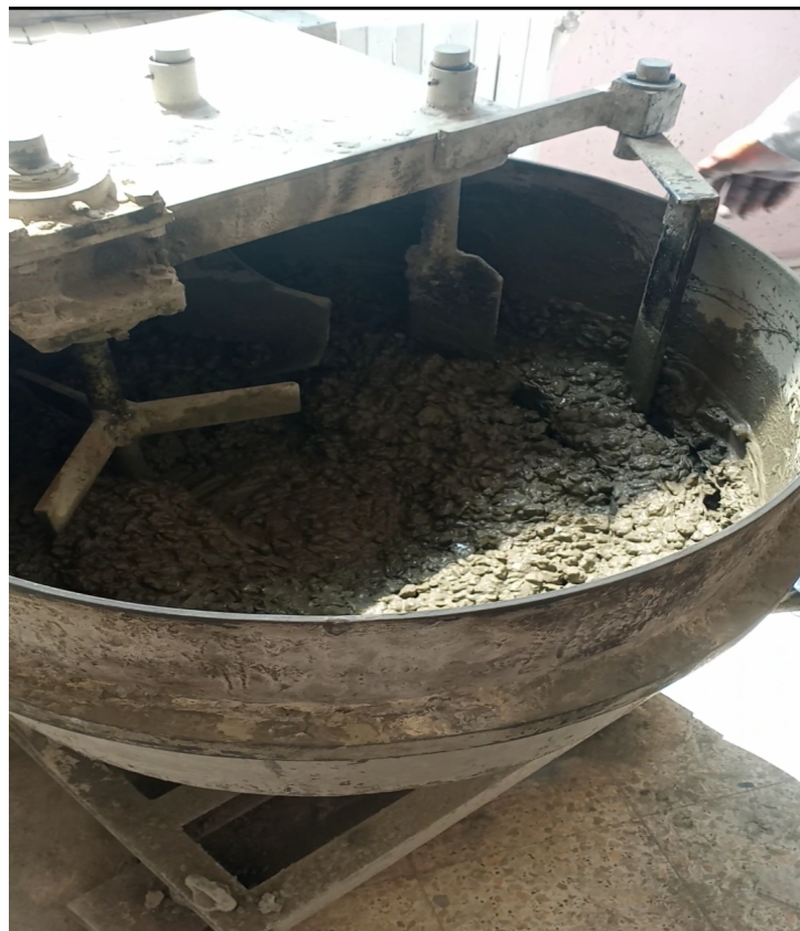
Figure III.28 : Le béton préparé.
