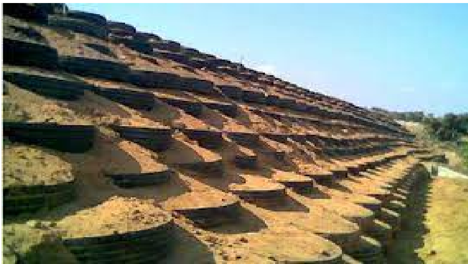
Figure II.1 : Chantier expérimental Pneu sol à Bou-SMAIL.
