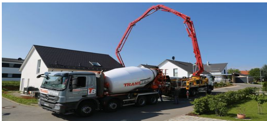
Figure I.14 : Le pompage du béton.
