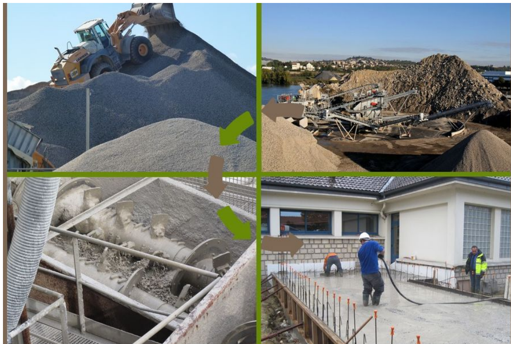
Figure II.4 : Utilisation des matériaux recyclés dans les bétons.
