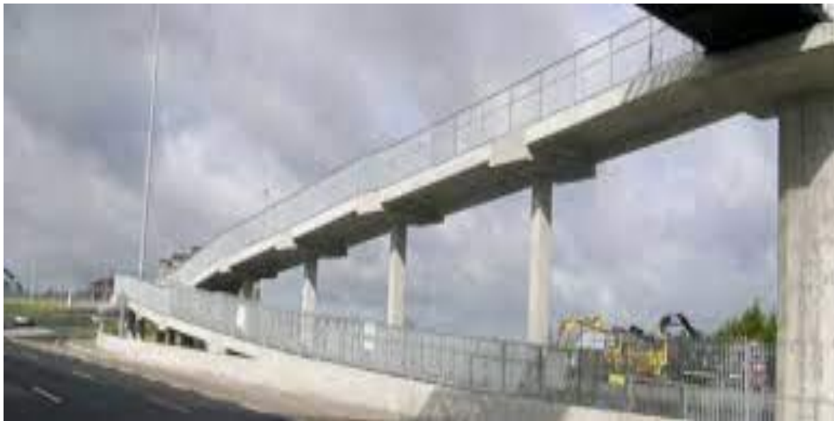
Figure VII.2: Pont en dalles en béton armé
