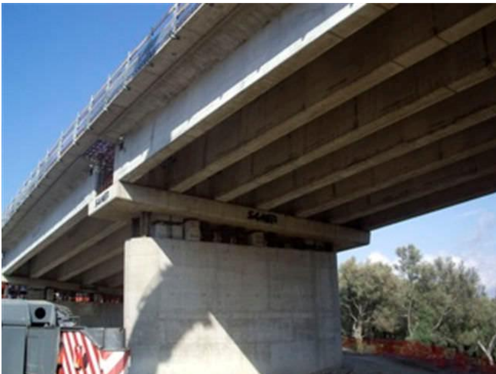
Figure VII.1: Pont a poutre en béton armée
