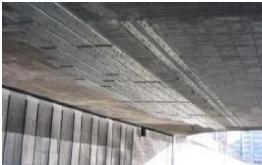
Figure II.5 : Renforcement par plats métalliques [BELBLIDIA Salima, 2018].
