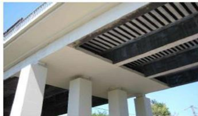
Figure II. 8 : Tablier de pont renforcé par matériaux composites [BELBLIDIA Salima, 2018].
