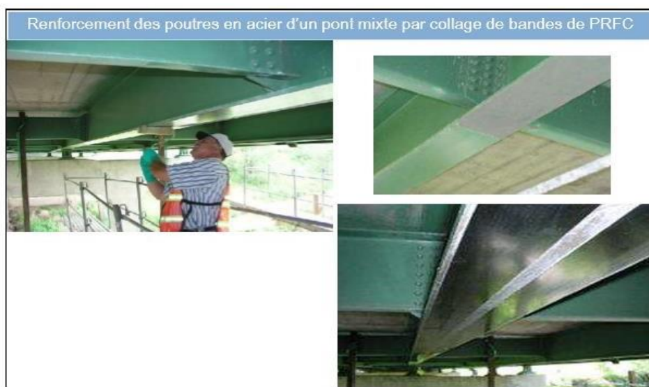
Figure II.6: Différentes méthodes de renforcement par le collage de plaques en composites.[Perrier R. et al , 1996].
