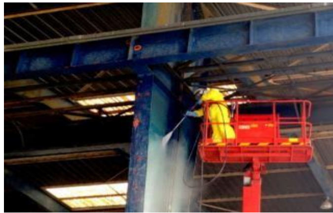
Figure II.1 : Décapage à l'eau (2, 2019)
