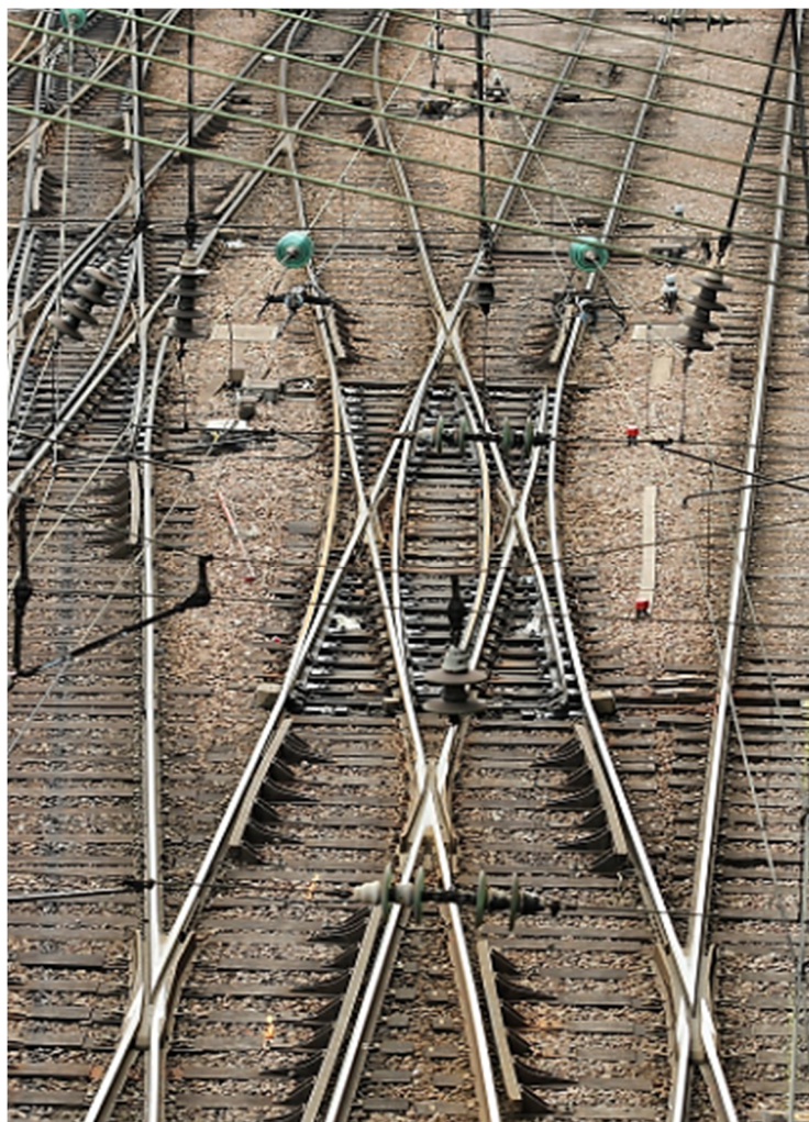
Figure VII.11. -La traversée-jonction double
