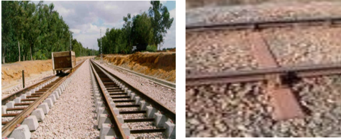
Figure VII.3.- Traverse en béton-Traverse en bois
