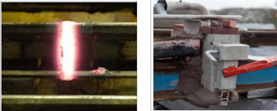
Figure VII.2. Le soudage aluminothermique
