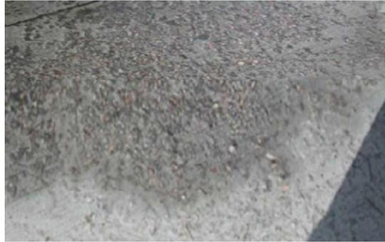
**Figure II.6.**Dégradation due aux sels de déverglaçage [26]
