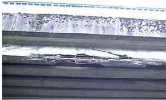
**Figure II.1.** Intrados des ponts dégradés [21]
