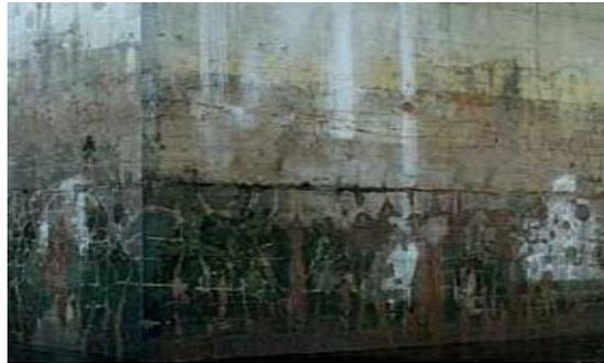
Figure II.2. Pile de pont atteinte par l'alcali-réaction[23]
