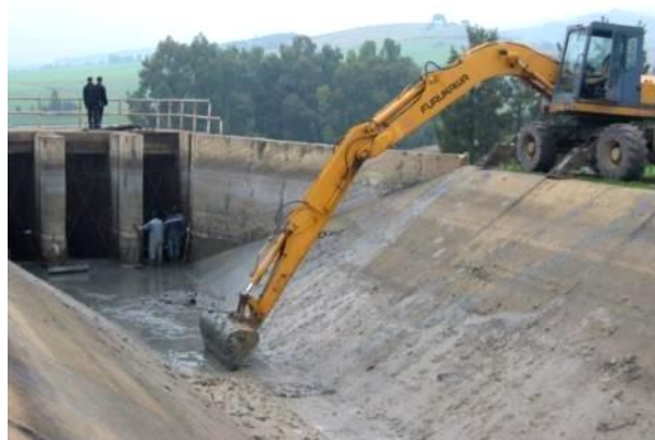
Figure IV. 10 : Curage d'un canal par les moyens mécaniques (Cliché. OPIM, 2008)
