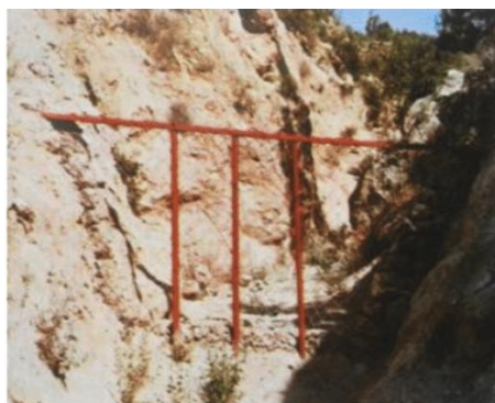
Figure VI.10 : Seuil en grillage avec piquets
