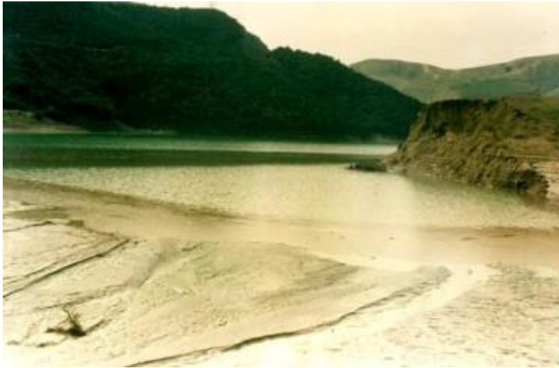
Figure IV.3 : Envasement du barrage d'Ighil Emda (cliché Ouaret, 2004)
