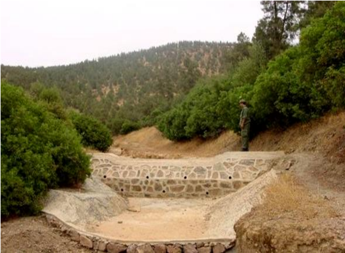
Figure V.5 : Seuil en maçonnerie
