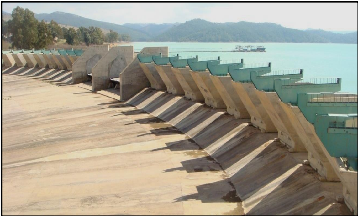
Figure IV.14 : Surélévation du barrage Ghrib par des hausses fusibles (Azzi, 2016).
