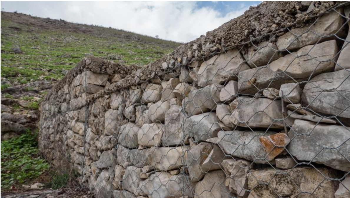
Figure V.4 : Seuil en gabion
