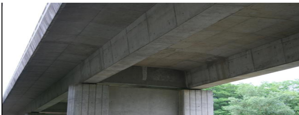
Figure I.16: un tablier à poutres latérales
