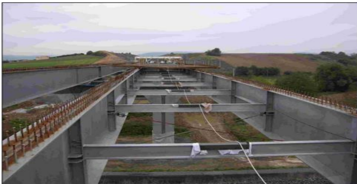
Figure I. 17: un tablier bipoutre mixte
