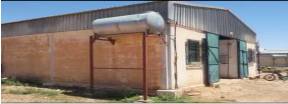
Annexe 04 : Installation des conduites d'eau dans les bergeries des ovins
