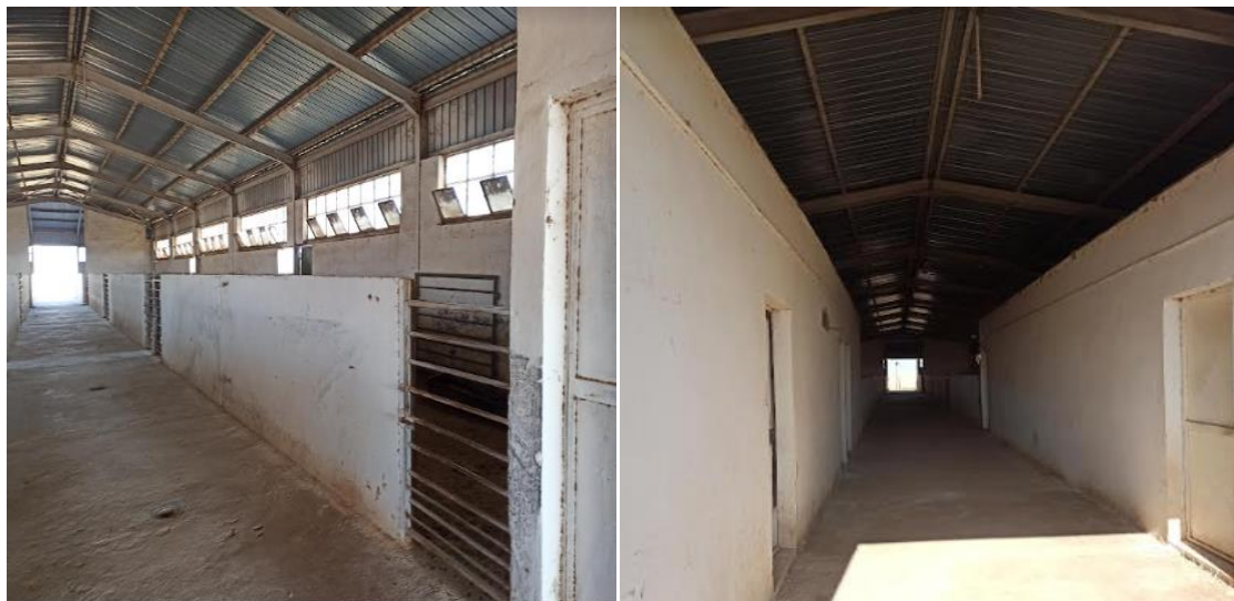
Figure 7. Bâtiments d'élevage de l'ITELV de Ksar Chellala (Photo personnelle, 2023)
