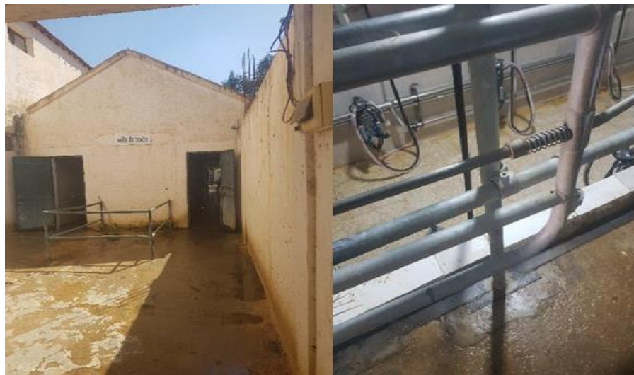
Figure 12 : salle de traite de la ferme BOUKHTECH
