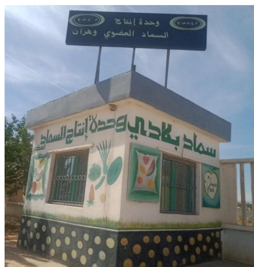
Figure 19: Unité de production compostage
