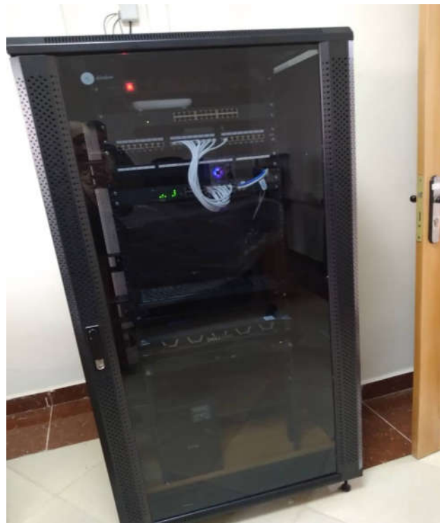
الشكل رقم(5): baie de brassage لوحة الوصلات
