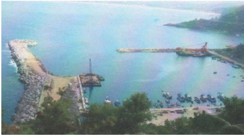
صورة رقم (15) توضح ميناء محطة شولو (القل حاليا)
