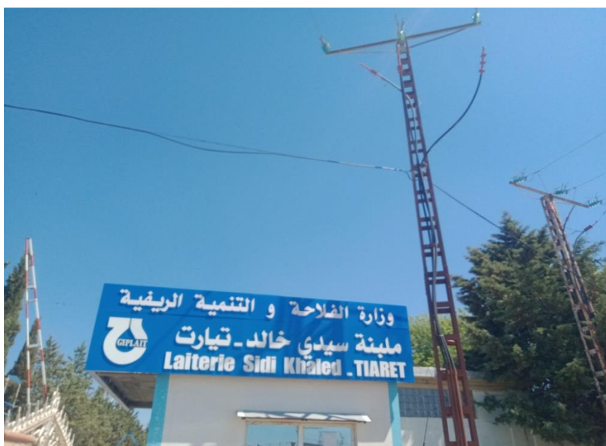
Figure 02 : Laiterie Sidi Khaled
