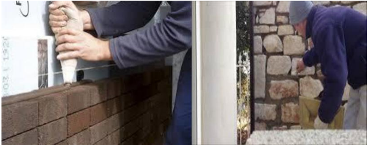
Figure 1.8. Les joints de maçonnerie.
