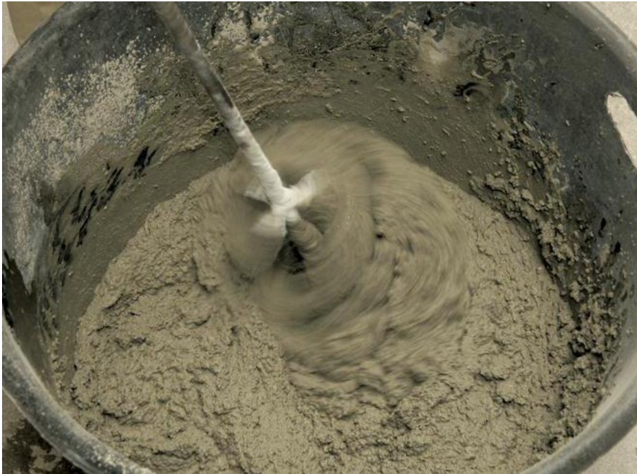
Figure. 1.1 : mélange de mortier.
