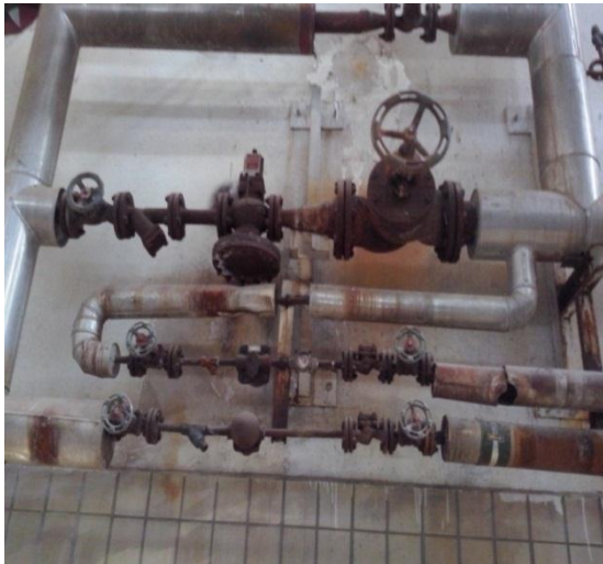
Annexe.1 la corrosion des canalisations au niveau de l'entreprise giplaitde aribs
