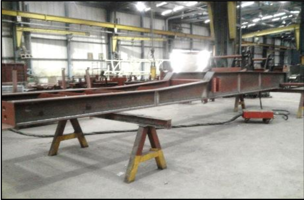
Figure II.10 : soudage du châssis
