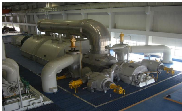
Figure II.3 : La turbine vapeur.
