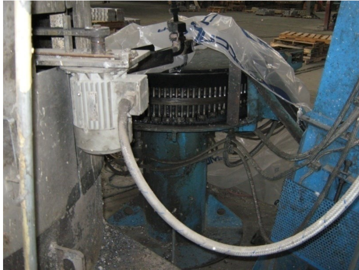
Figure (II.09) : Machine de construction des cylindres de plomb.
