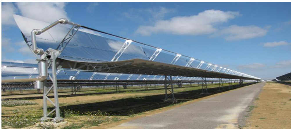
Figure I-22 : les capteurs cylindro-paraboliques.
