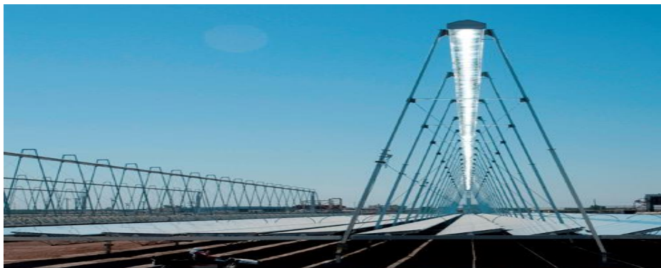
Figure I-23 : Centrale solaires à miroirs de Fresnel
