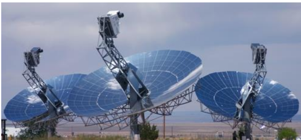
Figure I-25 : Centrale à capteurs paraboliques
