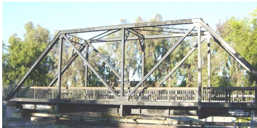
Figure 1.10: Pont en Treillis [11]
