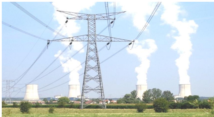
Fig.1.3 : Photo d'un Pylône de ligne électrique haute tension [4]
