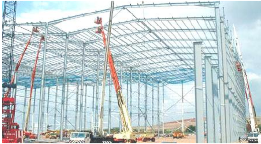
Fig.1.4 : Photo d'un Bâtiment industriel de grande hauteur [5] [20]
