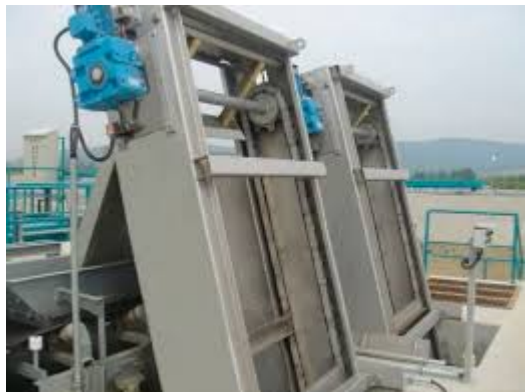
Figure 01: Dégrilleur.
