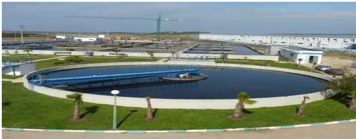
Figure 05: Décanteur secondaire.
