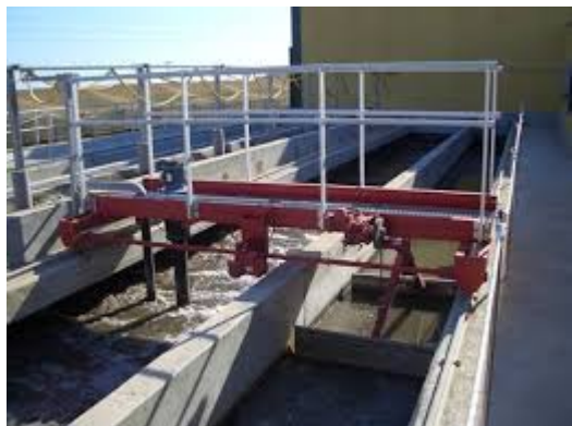
Figure 03: Déssableur /Déshuilleur. d
