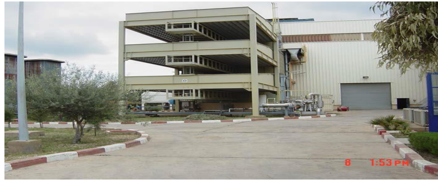
Figure I. 8 : Systèmes de filtration d'air.
