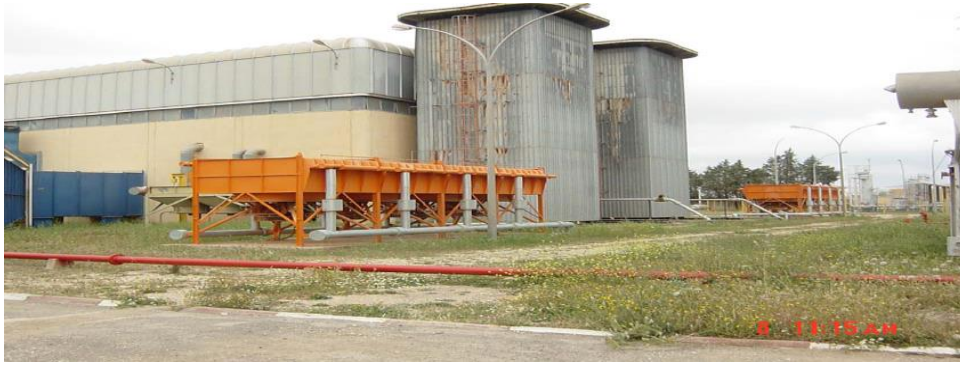
Figure I.5 : Réfrigérants d'huile.
