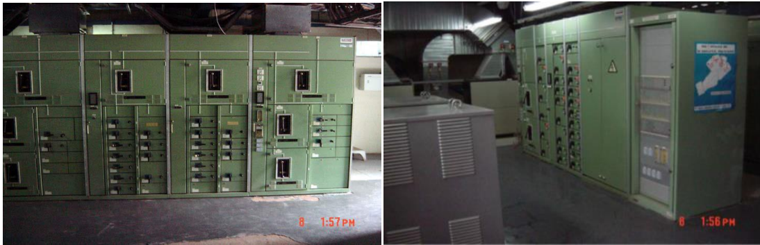
Figure I.13 : Tableau S.G.P et le Tableau C.C.M.
