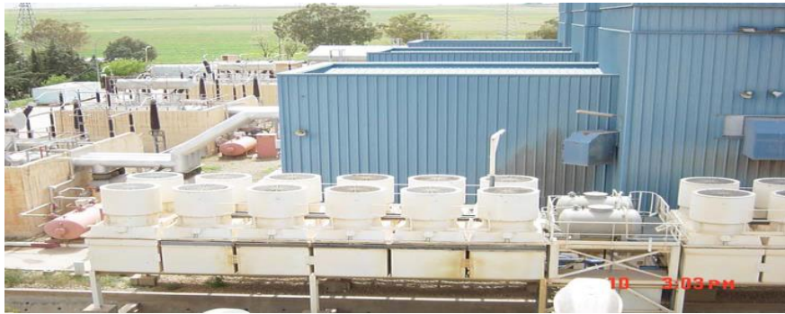
Figure I.9: Aéro réfrigérant.
