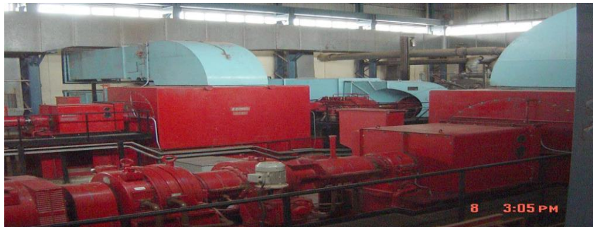
Figure I.2 : Groupe Turboalternateur FIAT TG20B2.
