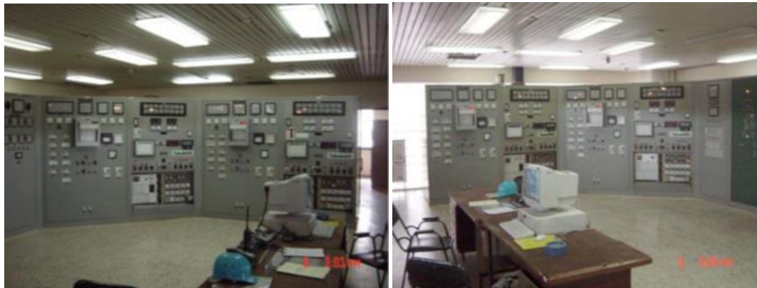
Figure I.15 : Tableau de synchronisation TSY.
