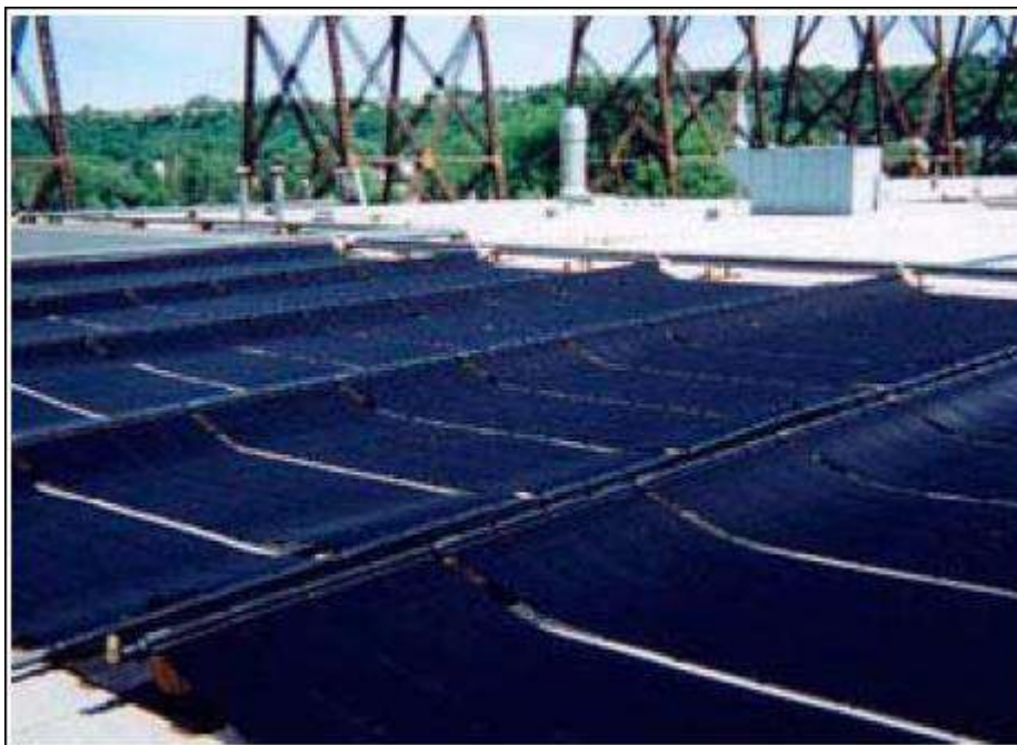
Figure III.10 : Capteur moquette pour le chauffage des piscines
