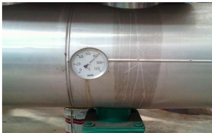
Figure-2.2- Indicateurs de température pour sortie d'eau
