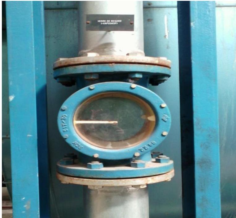
Figure-2.5- indicateur de niveau d'eau a réflexion
