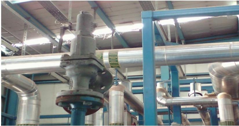
Figure-2.3- soupape de contrôle
