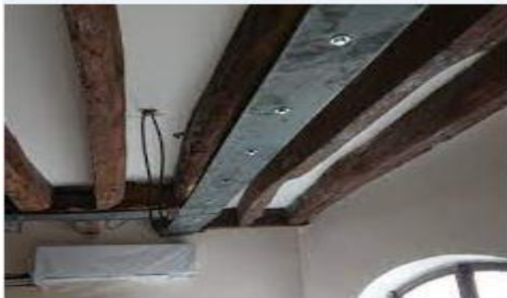
Figure. I.5 : Réparation par boulonnage.
