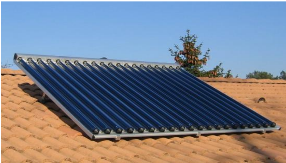
Figure I.8: Capteur à tubes sous vide
