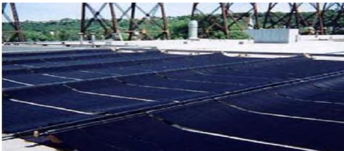
Figure I.6: Capteur solaire sans vitrage
