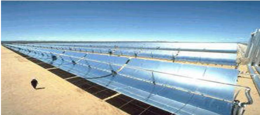
Figure I.10: Capteur cylindro-parabolique
