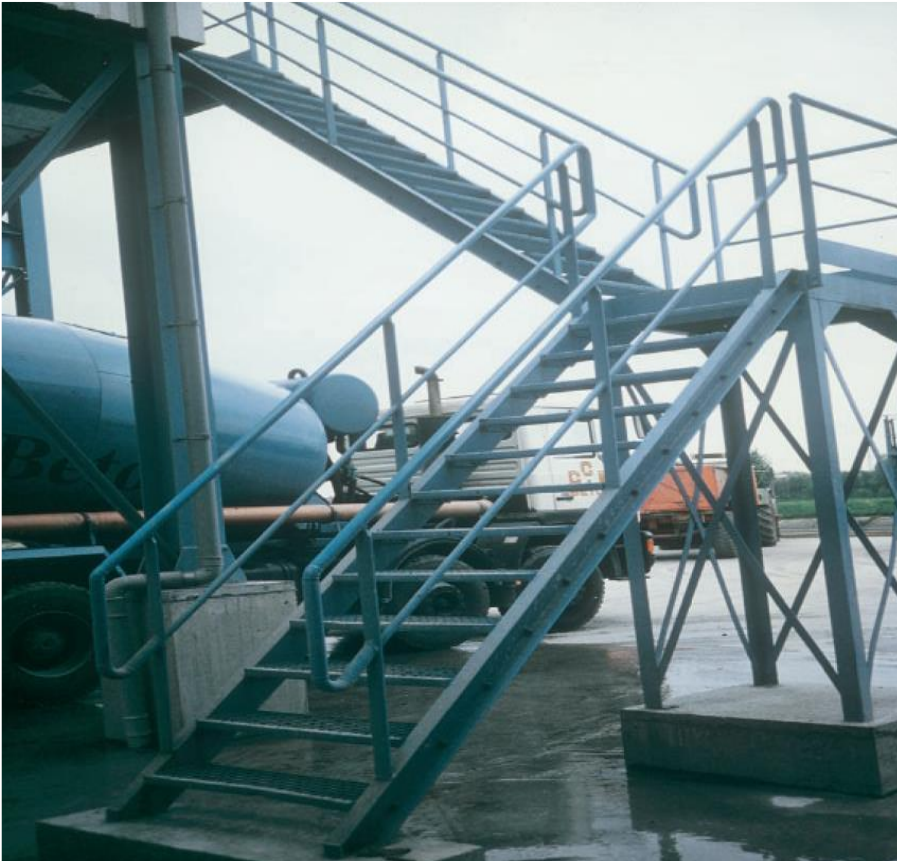
Figure III.7 : Photo des escaliers de centrale à béton.
