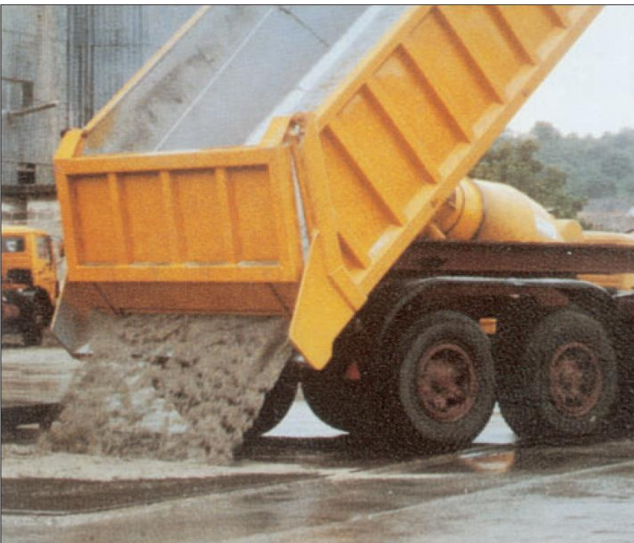
Figure III.5 : Photo d'un camion à transport le béton.
