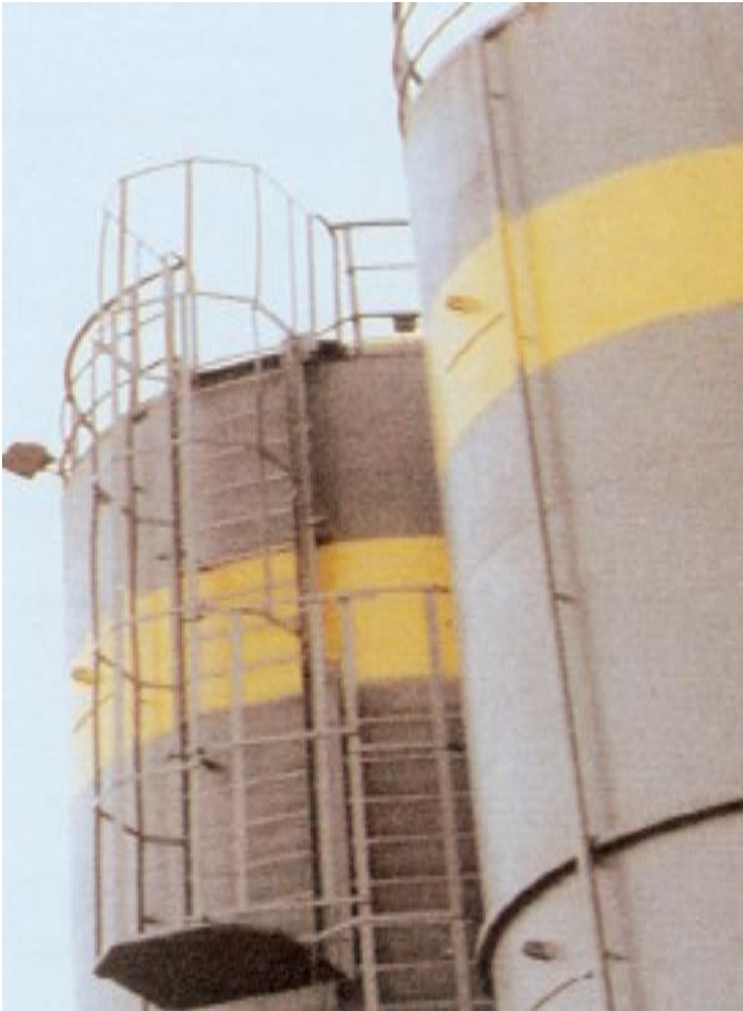
Figure III.9 : Photo des échelles fixes utilisées dans les centrales à béton.
