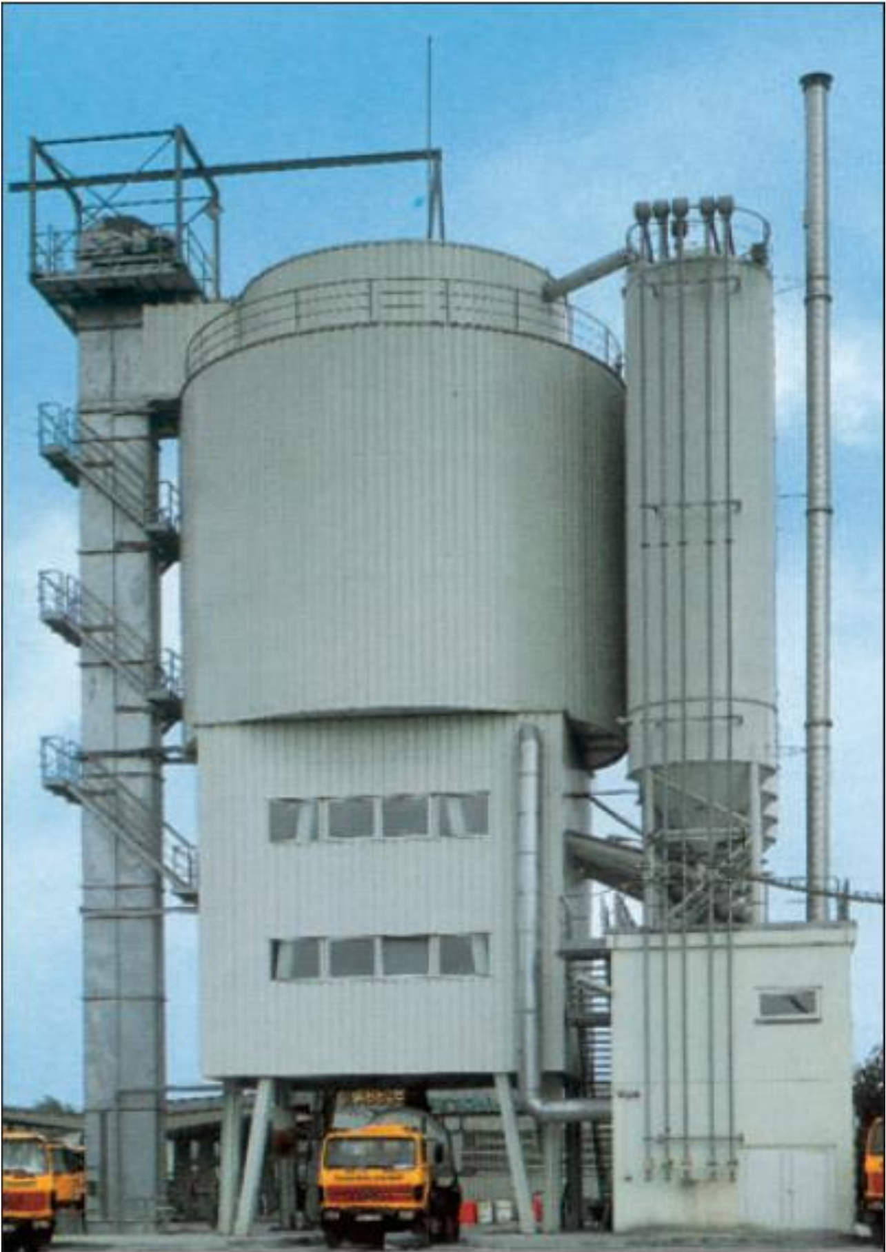
Figure I.1 : Photo générale d'une centrale à béton.
