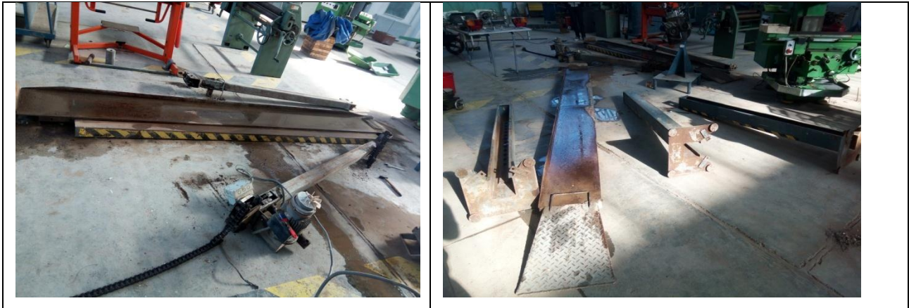
Figure III. 1 : le pont dans l'état initial
