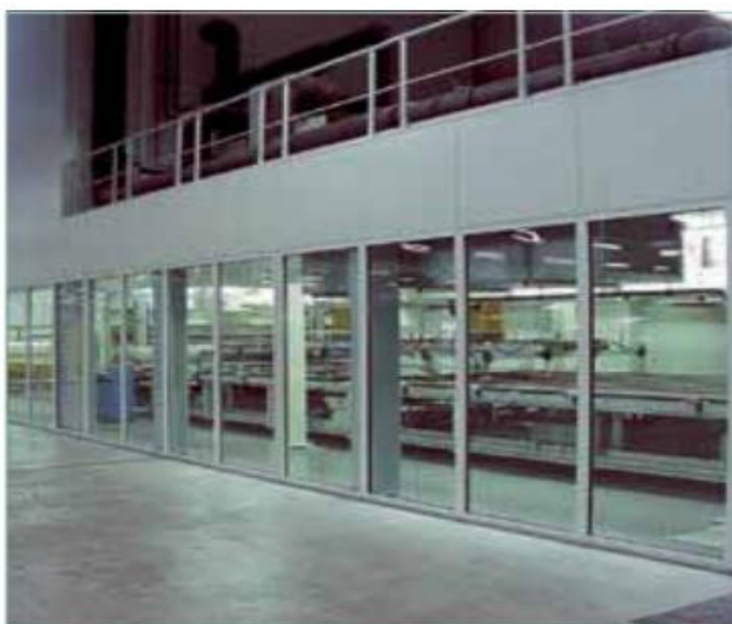
Fig.II.19. Chambre de laminage
