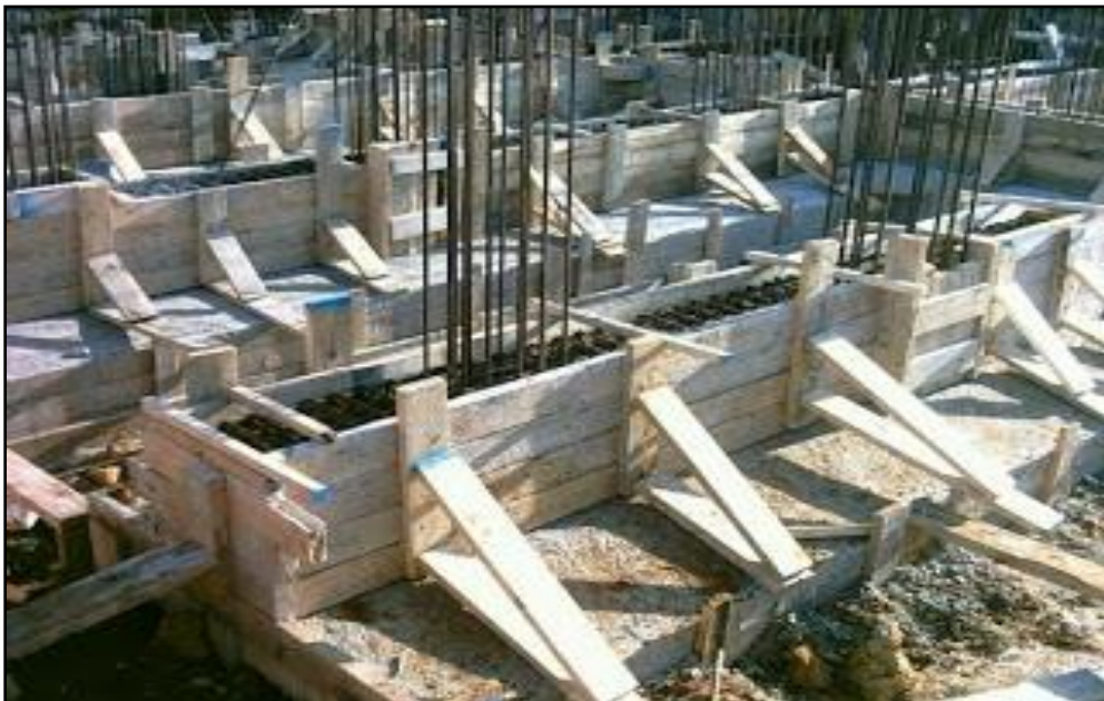
Figure VII-2 : 2 ème type de fondation « semelle filante »
