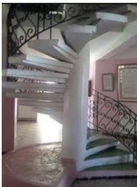
Figure I-6 : Exemple d'escalier hélicoïdal
