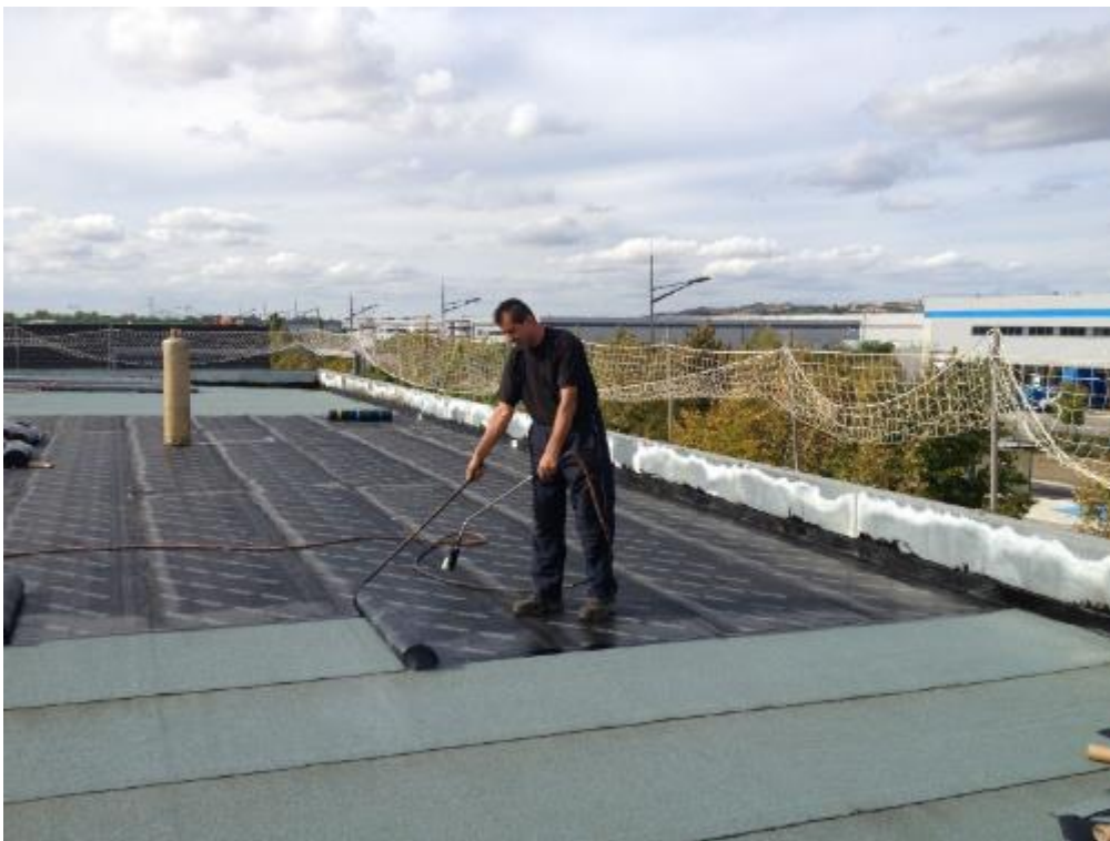
figure I-7 :étanchéité multicouches
