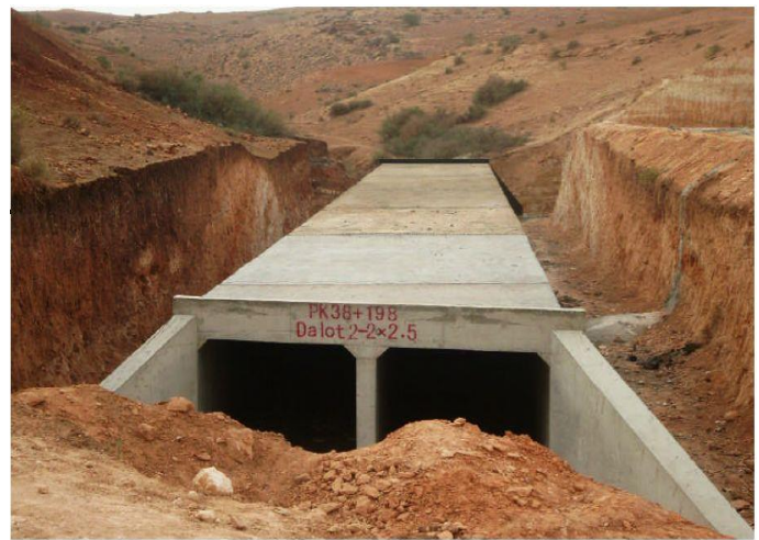
Figure VI.2 : Dalot à double ouvertures
