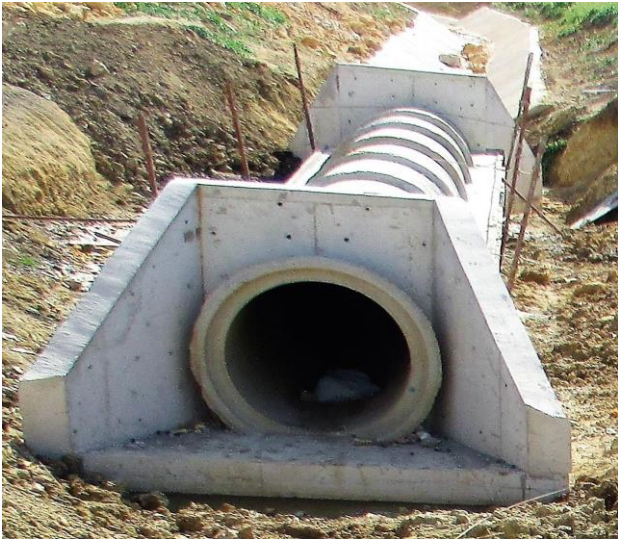
Figure VI.3 : Buse simple
