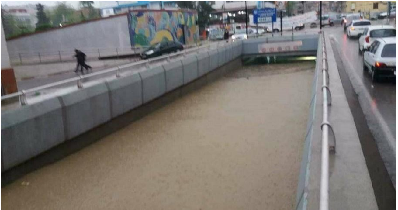
Figure 4 : Tunnel REGINA-Tiaret inondé après de fortes averses Avril-2018.
