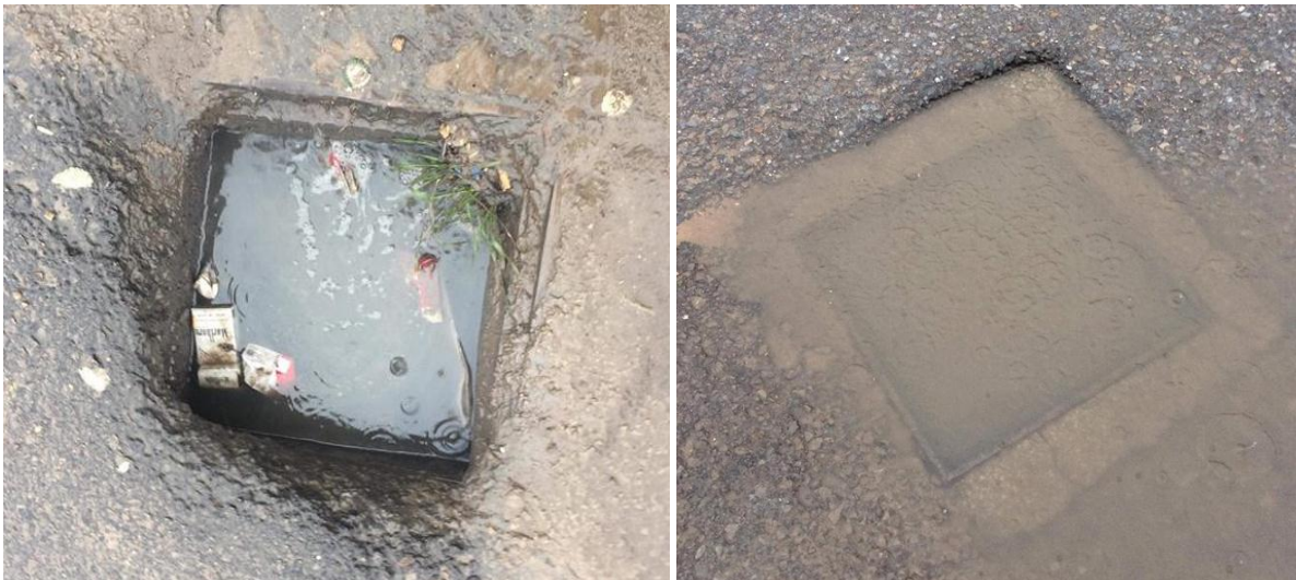
Figure 3 : Avaloirs ensablés, couvert par l'enrobage de la couche de roulement CITE BADR.
