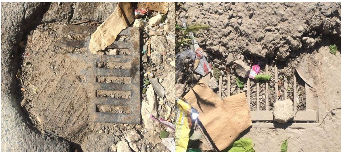
Figure 3 : Avaloirs ensablés, couvert par l'enrobage de la couche de roulement CITE BADR.
