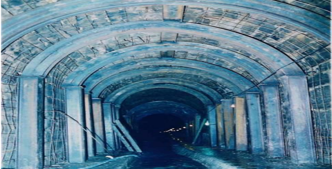
Figure II.8 : Etat de la galerie souterraine après la réhabilitation
