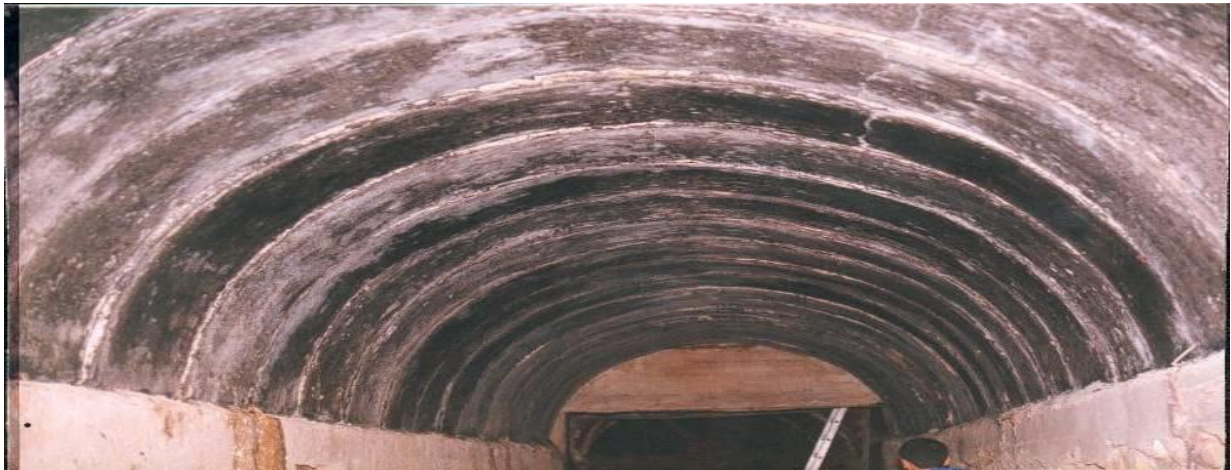
Figure II.6 : Effondrement 1998-dégradations très avancées de la structure (avant la réhabilitation)
