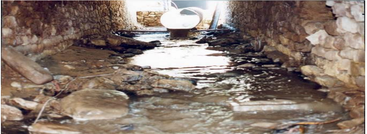
Figure II.6 : Effondrement 1998-dégradations très avancées de la structure (avant la réhabilitation)
