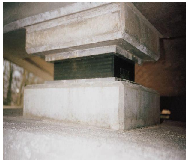
Figure IX.7 : Appareil d'appui
