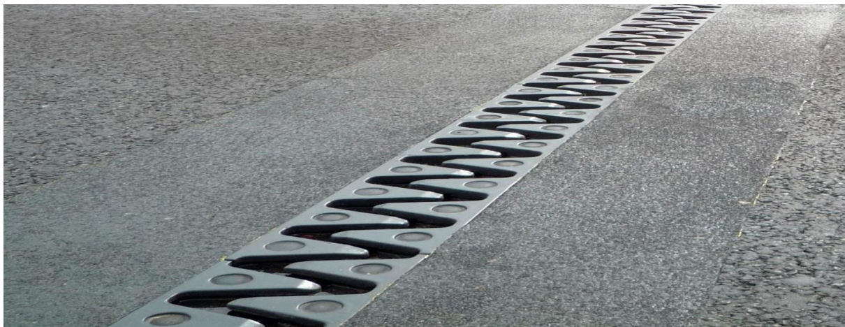
Figure IX.8 : Joint de chaussée
