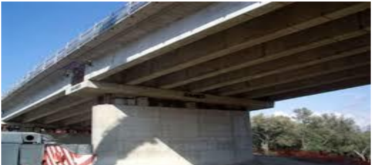
Figure IX.3 : Pont à poutres en béton armé
